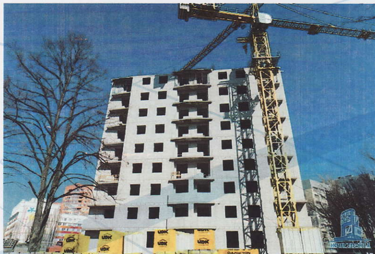
Будівництво ЖК «Дует» (II черга) станом на березень 2017 року
