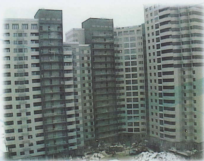
Будівництво ЖК «Острівського, 40» станом на грудень 2013 року
