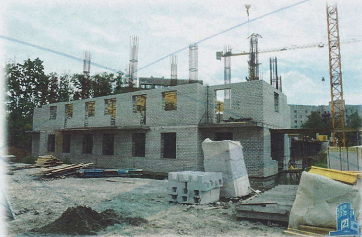
Будівництво ЖК «Дует» (II черга) станом на вересень 2016 року
